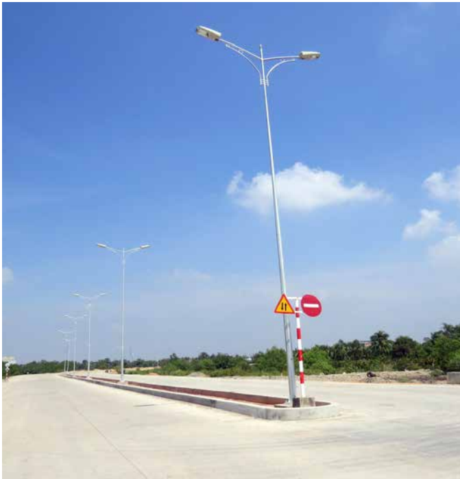
- Chủ đầu tư: Công ty cổ phần xi măng Hà Tiên 1. / Investor: Ha Tien 1 Cement Joint Stock Company - Xây dựng đường nối từ đường Nguyễn Duy Trinh vào Khu công nghiệp Phú Hữu, Quận 9, TP.HCM / Construction of road from Nguyen Duy Trinh Street to Phu Huu Industrial Park, District 9, HCMC - Giá trị công trình / Value of work: 314.843.882.601 VND (phần của Công ty CP CTGTCC - part of CPW JSC: 156.724.985.970 VND) - Thời gian thi công / Duration of construction: 2011 - 2016 - Loại, cấp công trình: Công trình giao thông, cấp II / Category: road; rank: II
