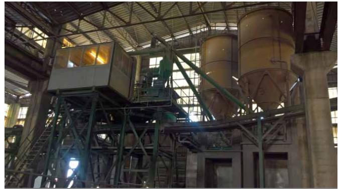
Trộn bê tông - Mix concrete
