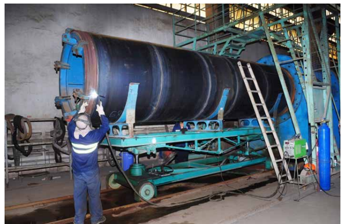
Thử áp lực nòng thép - Pressure test of steel cylinder
