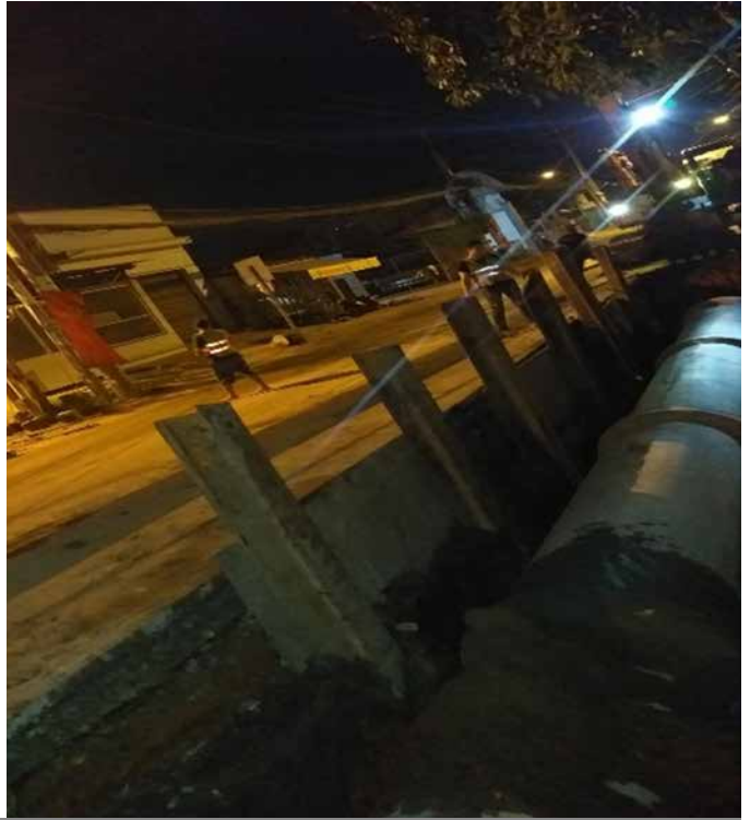
Dan Cong Street; Package: Construction - Location: Vinh Loc A Ward, Binh Chanh District, HCM City - Giá trị công trình / Value of work: 85.873.679.747 VND - Thời gian thi công / Duration of construction: 2019-2020 - Loại, cấp công trình: Đường giao thông, cấp III / Category: road; rank: III
