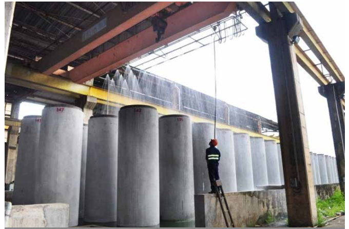
Bảo dưỡng bằng nước - Maintenance by water
