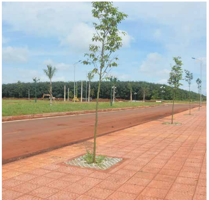
- Chủ đầu tư: Sở khoa học công nghệ tỉnh Đồng Nai. / Investor: Dong Nai Department of Science and Technology - Đầu tư hạ tầng kỹ thuật Trung tâm ứng dụng công nghệ sinh học Tỉnh Đồng Nai, Xã Xuân Đường, Huyện Cẩm Mỹ, Tỉnh Đồng Nai (giai đoạn 1); Gói thầu số 1 / Investment of infrastructure in Dong Nai Biotechnology Center, Xuan Duong Ward, Cam My District, Dong Nai Province (phase 1); Package 1 - Giá trị công trình - Value of work: 213.348.627.000 VND (phần của Công ty CP CTGTCC - part of CPW JSC: 197.134.257.000 VND) - Thời gian thi công - Duration of construction: 2015 - 2017 - Loại, cấp công trình: Công trình giao thông, cấp III / Category: road; rank: III
