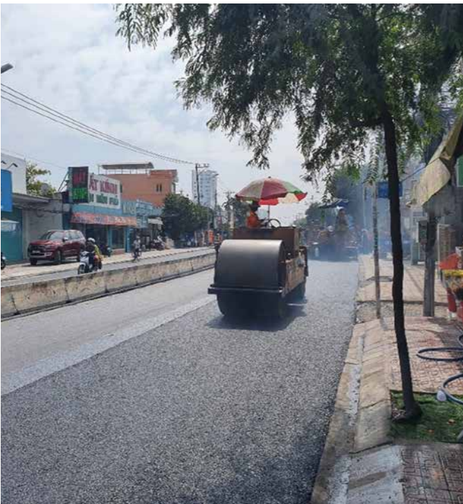
- Chủ đầu tư: Ban Quản lý dự Án Đầu tư Xây dựng Các công trình Giao thông / Investor: Management Board of Investment and Construction Projects Transport works. - Dự án: Xây dựng hệ thống thoát nước và cải tạo mặt đường Huỳnh Tấn Phát (Đoạn từ cầu Phú Xuân đến phà Bình Khánh); Gói thầu: Xây lắp 1 (Đoạn từ Km0+000 - Km1+680) - Địa điểm xây dựng: huyện Nhà Bè, Tp.HCM / Project: Building drainage system and improving Huynh Tan Phat road surface
