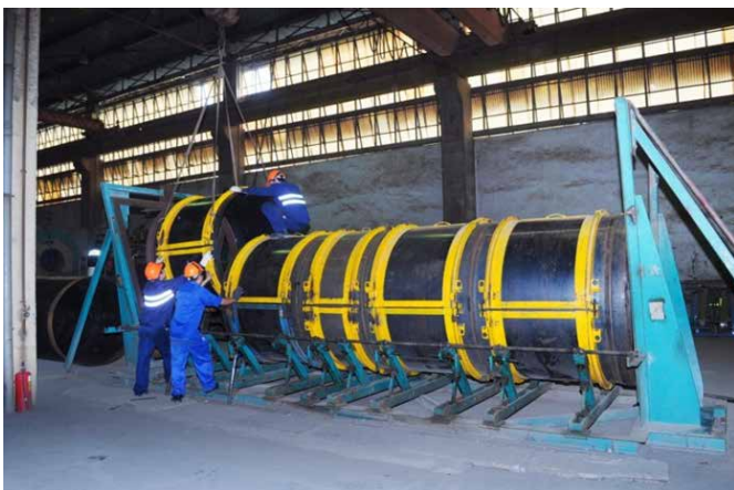
Lắp ghép nòng thép - Steel cylinder assembling
