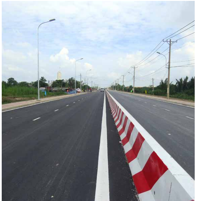
- Chủ đầu tư: Ban quản lý các khu liên hợp xử lý chất thải Đa Phước. / Investor: Đa Phước Waste Treatment Complex Management Board - Xây dựng cầu, đường giao thông từ Khu liên hợp xử lý rác thải Đa Phước đến Quốc lộ 50 / Construction of bridge, road from Đa Phước Intergrated Waste Management Facility to National Road 50 - Giá trị công trình - Value of work: 76.544.355.915 VND - Thời gian thi công - Duration of construction: 2012 - 2013 - Loại, cấp công trình: Công trình giao thông, cấp III / Category: road; rank: III
