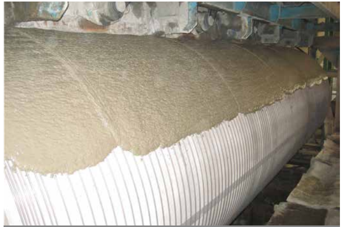
Phủ bê tông bảo vệ / Concrete covering
