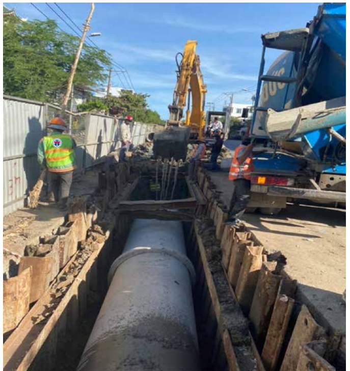
(section from Phu Xuan bridge to Binh Khanh ferry); Package: Construction and installation 1 (Section from Km0+000 - Km1+680) - Construction site: Nha Be district, HCMC. - Giá trị công trình/Value of work: 74.533.072.937 VNĐ. - Thời gian thi công / Duration of construction: 2020-2021. - Loại, cấp công trình: Đường giao thông, cấp II / Category: road, rank: II.
