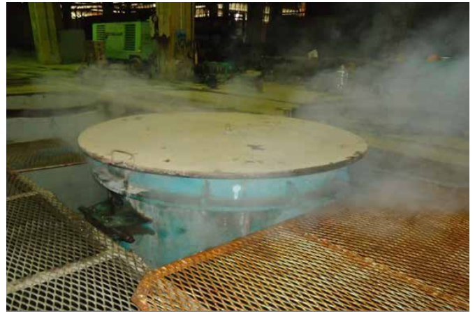
Bảo dưỡng bằng hơi - Maintenance by steam
