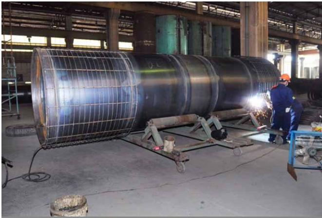
Ghép ống vào nòng thép - Assemble pipe into steel cylinder
